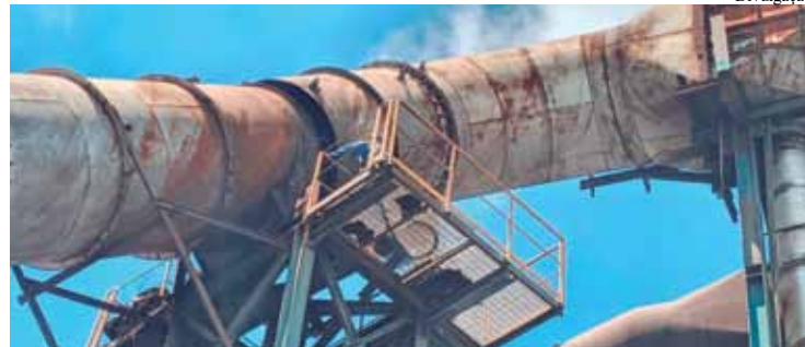
Início do reparo no duto do "despoeiramento"
