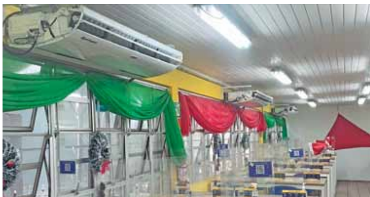
Aparelhos de ar-condicionado sendo instalados no restaurante central da fábrica
