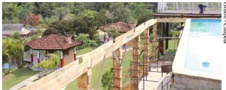
Madeiramento foi retirado e está sendo substituído por vigas e laje de concreto
